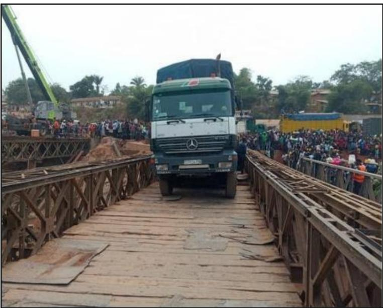
Le trafic est interrompu sur le pont Tshikapa depuis lundi 13 juillet. Il a été sérieusement endommagé par le passage d'un gros camion transportant des sacs de ciment. Selon des témoignages sur place, le véhicule s'est enfoncé dans le pont qui n'a pas supporté la charge.
