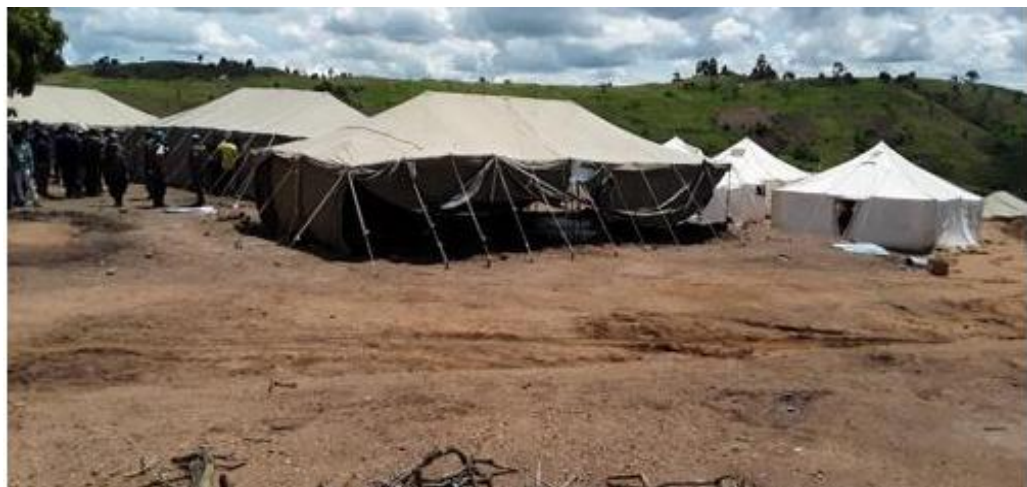
La construction de deux sites de désarmement et démobilisation de la milice FRPI dans la chefferie de WalenduBindi par la MONUSCO. Photo MONUSCO.
