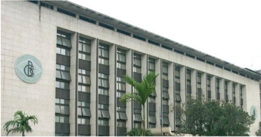
Une des façades du bâtiment administratif de la BCC
