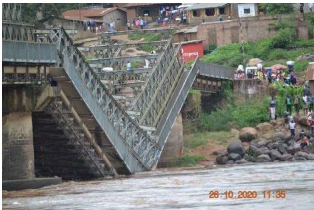
Le pont Kasaï construit avant l'indépendance du pays a été sollicité de manière intensive ces derniers mois. Il s'est effondré vendredi 23 octobre 2020 au passage d'un gros camion. Photo droits tiers.
